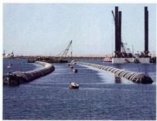
ta densidad (PE-100) de 2.000 mm de diámetro externo y SDR 26 (espesor medio de 80,8 mm), con una longitud total de 3.810 m (los últimos 526 m constituyen el difusor) y un trazado con un ángulo de 101° respecto del Norte. La cañería se preveía instalar en trinchera, para lo cual se prepararon 6 tramos de 300 m y 6 tramos de 312 m de longitud, con lastres de hormigón armado de 18.000 kg cada 6 m, los que transitoriamente fueron acopiados en flotación en el puerto de Mar del Plata.
